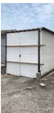
補修されたフォークリフト小屋の扉
