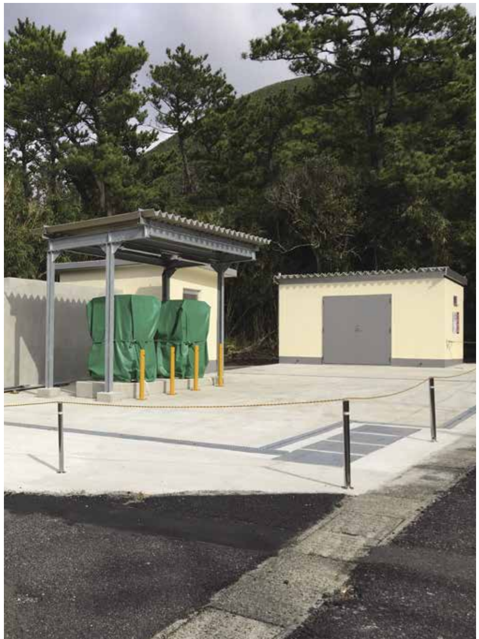
完成した硫黄島給油所
