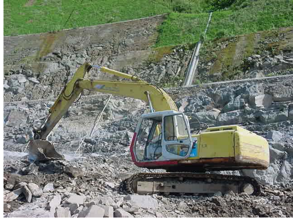
工事をしているようす
