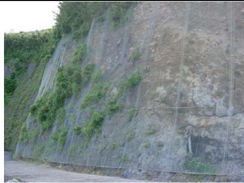
がけくずれを防ぐためのネット
