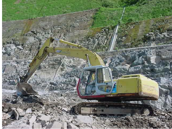
工事をしているようす
